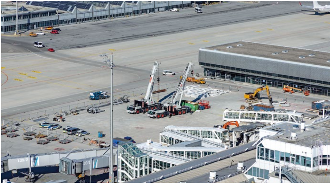
Anfang März 2019 begannen die Bauarbeiten auf dem Vorfeld West.
