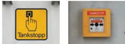
Bei Schäden an der Tankanlage während der Betankung von Luftfahrzeugen ist durch Drücken des Notschalters der angeschlossene Unterflurhydrant zu schließen und die Feuerwehr zu ver-
