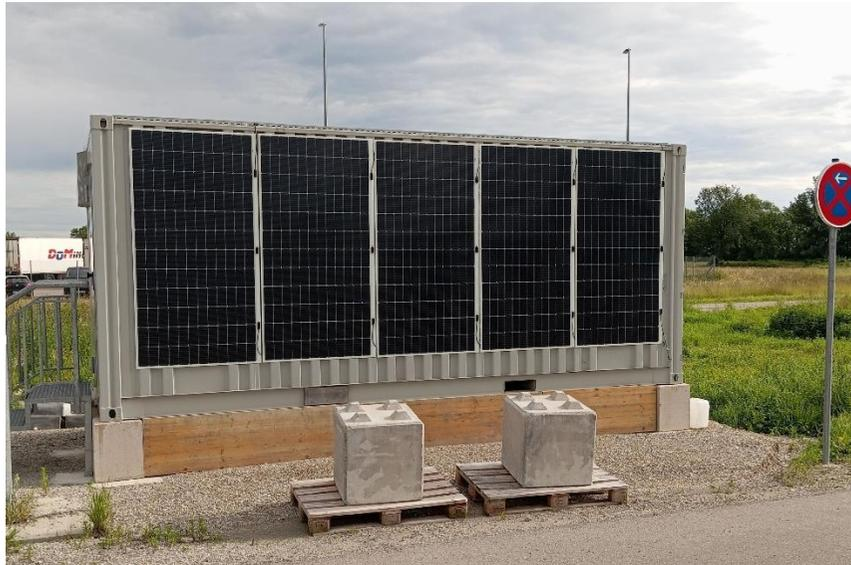
Die Lehrwerkstatt der Flughafen München GmbH (FMG) hat in Zusammenarbeit mit dem Energiemanagement ein innovatives Anlagenkonzept umgesetzt: Insgesamt zehn Solarmodule, die auf die Fassade und das Dach eines Containers am Mietwagendepot P36 montiert wurden, erzeugen nun Strom.
