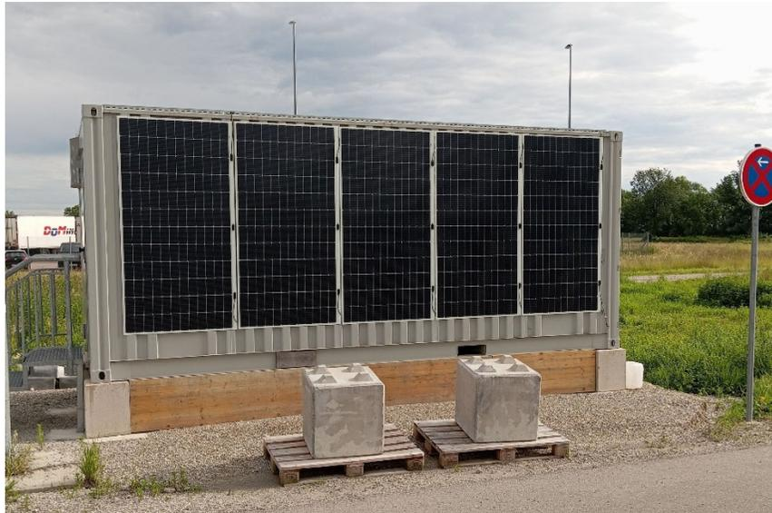
Die Lehrwerkstatt der Flughafen München GmbH (FMG) hat in Zusammenarbeit mit dem Energiemanagement ein innovatives Anlagenkonzept umgesetzt: Insgesamt zehn Solarmodule, die auf die Fassade und das Dach eines Containers am Mietwagendept P36 montiert wurden, erzeugen nun Strom.
