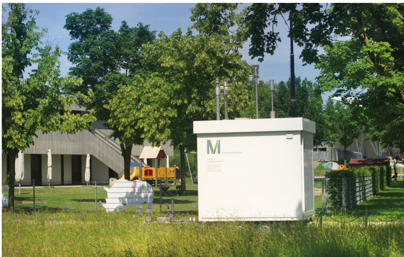
13 Außenansicht der mobilen Luftgütemessstation an der Kita »Airport Hopser« im Besucherpark des Flughafens
