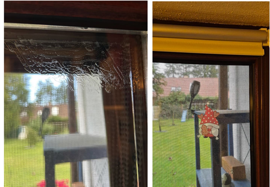
Austausch optisch beeinträchtigter Gießharzscheiben: links vor, rechts nach dem Scheibentausch.
