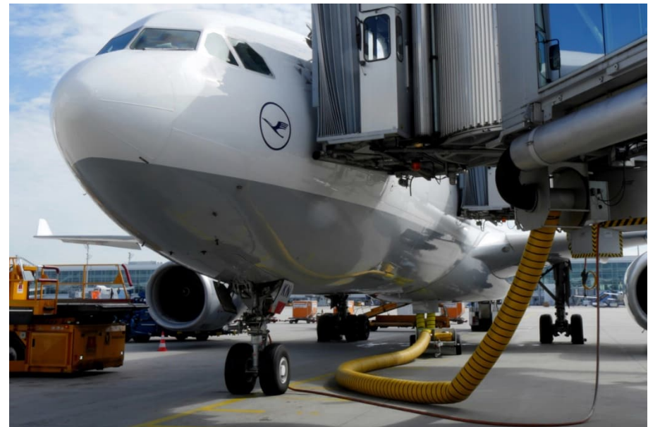
Nutzung einer »Pre-Conditioned-Air«-Anlage (PCA)
