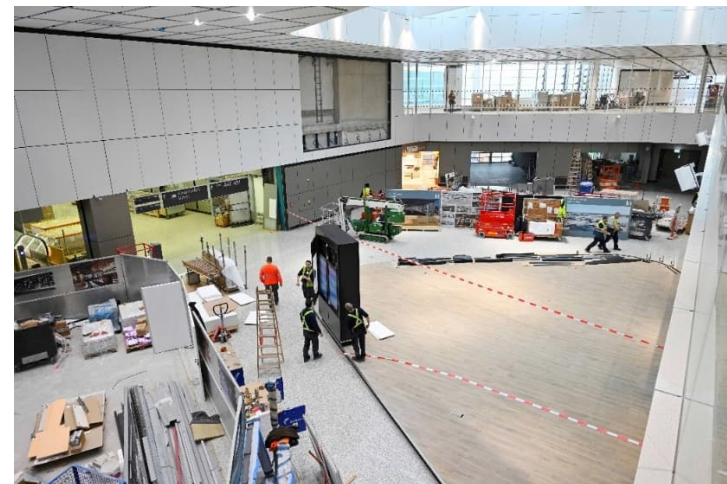
Innenausbau im Terminal 1 - Pier
